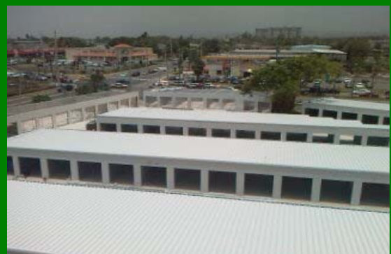
Techo sobre Mini Warehouse de Carolina
