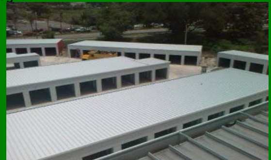
Techo sobre Mini Warehouse de Carolina
