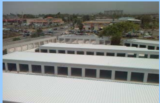
Techo sobre Mini Warehouse de Carolina
