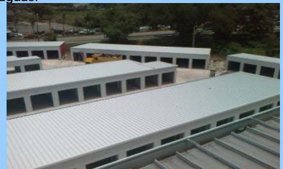
Techo sobre Mini Warehouse de Carolina
