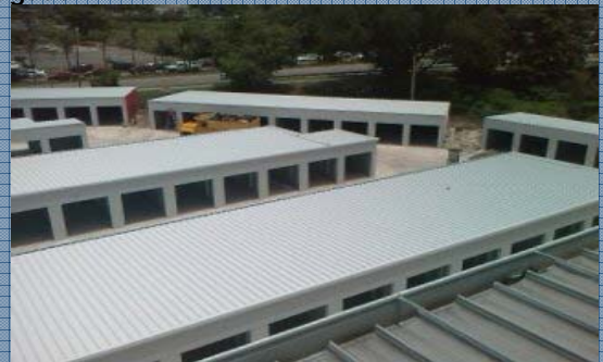
Techo sobre Mini Warehouse de Carolina
