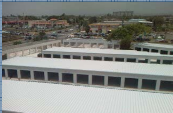
Techo sobre Mini Warehouse de Carolina
