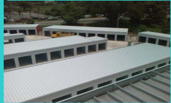
Techo sobre Mini Warehouse de Carolina
