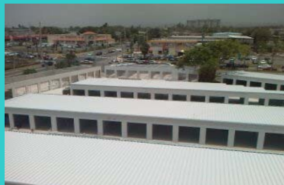
Techo sobre Mini Warehouse de Carolina
